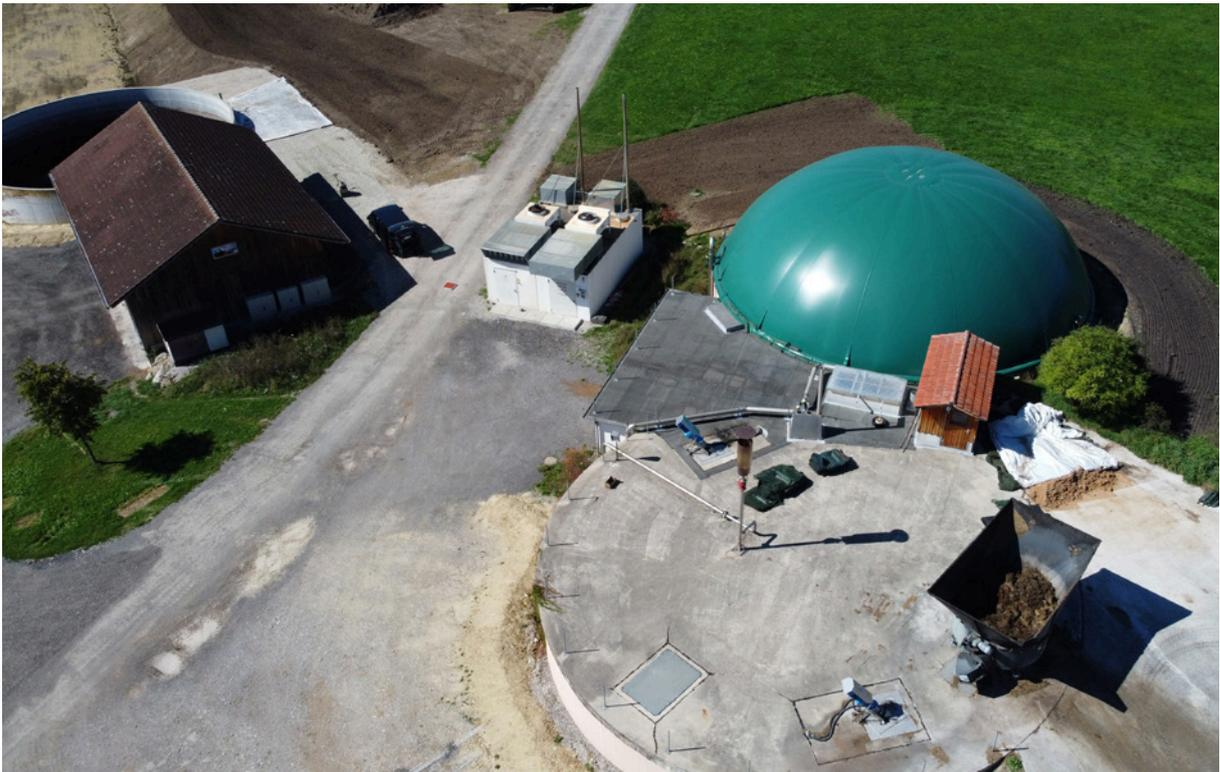
**Abbildung 21:** Nassfermentationsanlagen sind an der Folienkuppel des Fermenters zu erkennen, in dem das Gas gespeichert wird. Sammelt sich dort Gas an, bläht sich die Kuppel auf.
