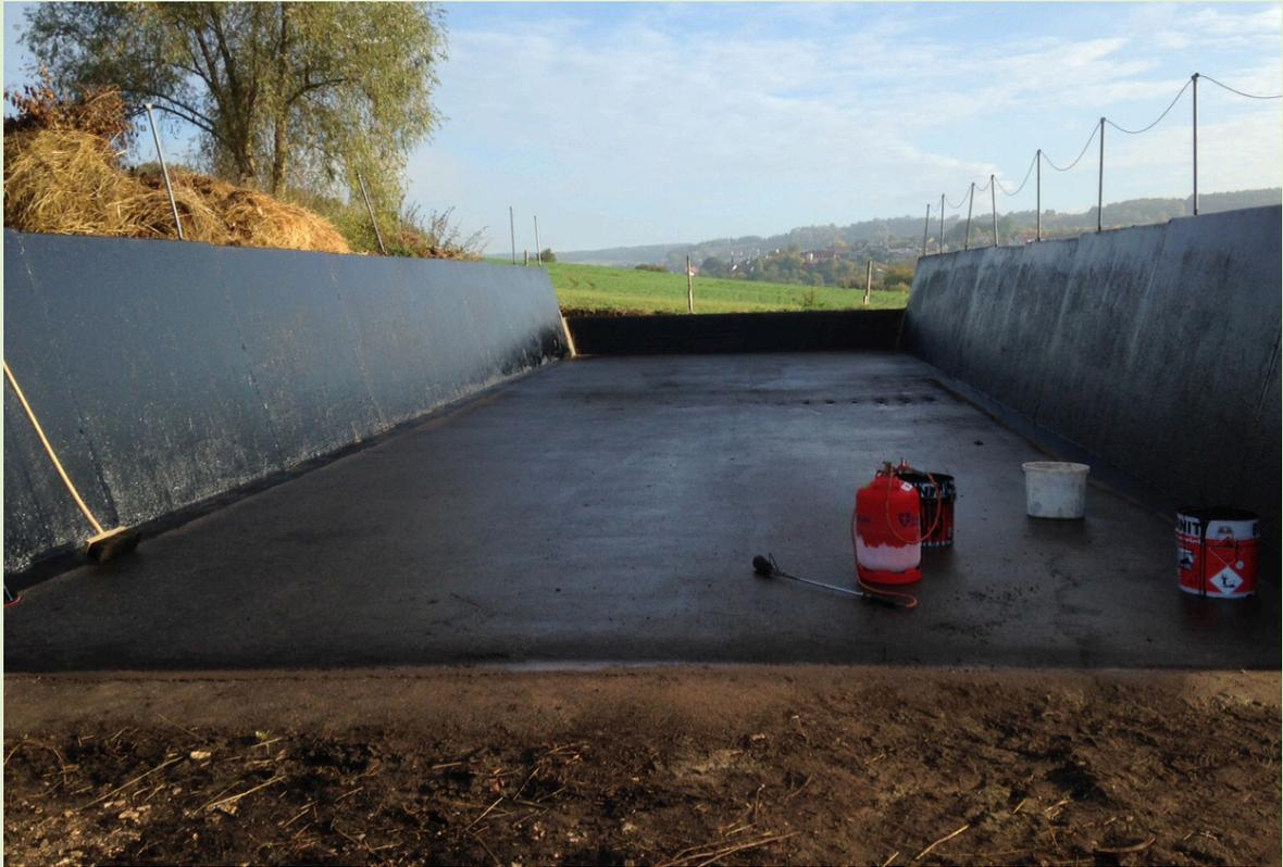
**Abbildung 11:** Die neu aufgetragene Lackschicht verhindert, dass Kompostsickerwasser durch das Fahrsilo ins Grundwasser gelangt. © LPV Mittelfranken
