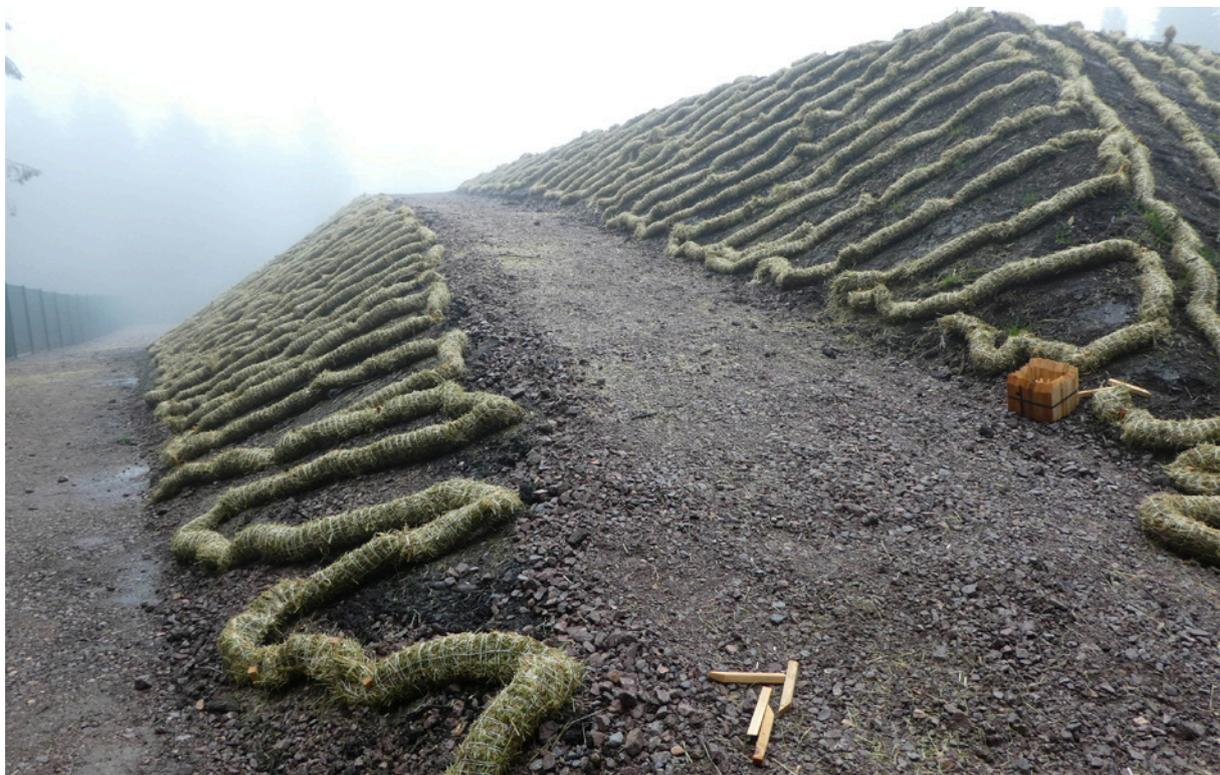
**Abbildung 30:** Die Faschinen aus Heu werden am Hang entlang abgelegt und mit Holzpflocken fixiert. Sie sorgen gleichzeitig für Erosionsschutz und Wiederbegrünung der Hangfläche. © DVL
