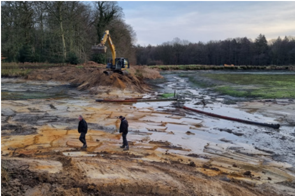
Die zusammengelegten Teiche nach den Erdarbeiten. Foto: DVL Schleswig-Holstein
