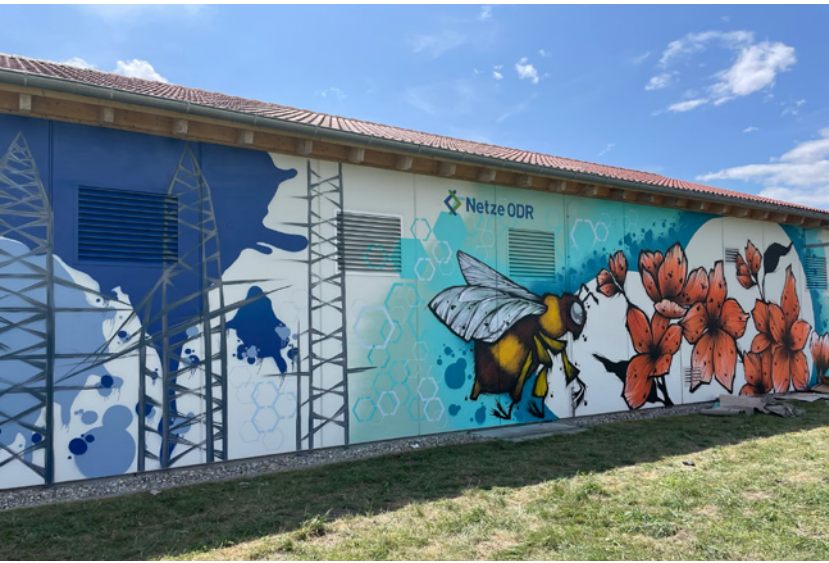
Wandgestaltung mit Auftrag der ODR (EnBW) am Umspannwerk in Gundelfingen. Foto: LPV Donautal-Aktiv e.V.
