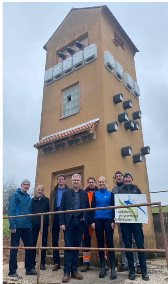
Von der Stromverteilung zum Artenschutz-Hotspot: ehemaliges Trafohaus in Stein. Foto: LPV Mfr
